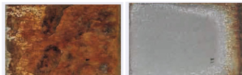
Vergelijking tussen Sendzimir verzinkt Z275 (links) en ZMA-bekleed Z140 na een versnelde atmosferische test van negen maanden.
